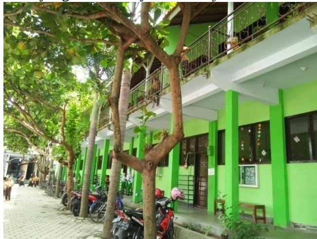
Gambar 4.3.4 dokumentasi bangunan ruang kelas 182
