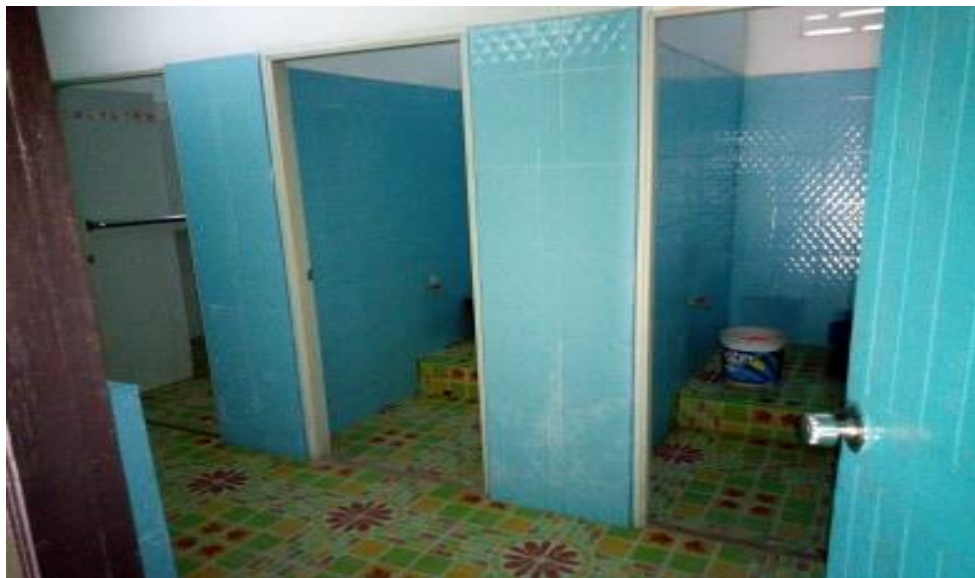
Gambar 9 Ruang WC guru Gambar ini menunjukkan ruang WC untuk guru Agama
