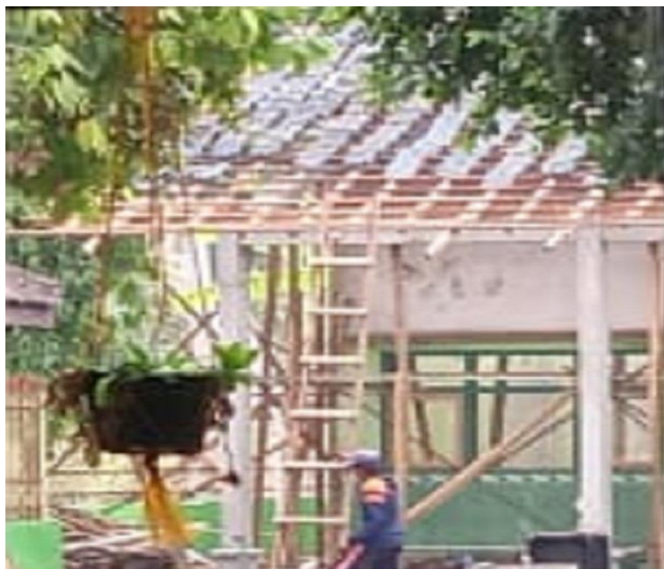
Gambar 4.14 Renovasi ruang kelas
