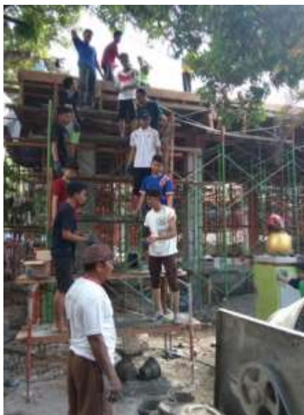
Gambar 4.12 Pembangunan Masjid At-Taqwa MAN 2 Kota Kediri
