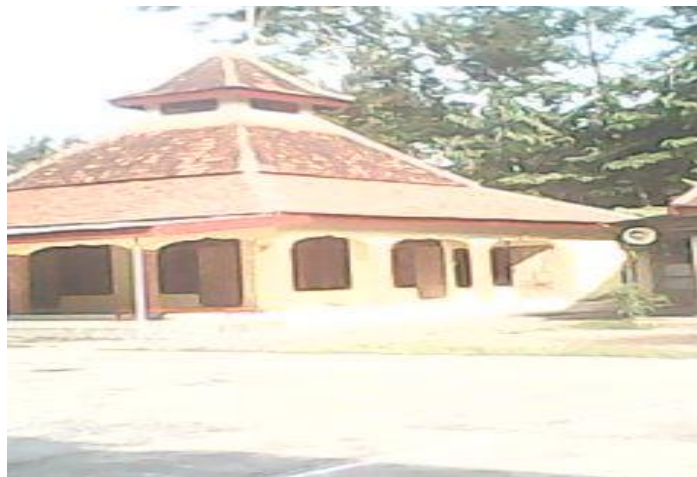
Gambar 2: Masjid MTsN Ngantru Tulungagung
