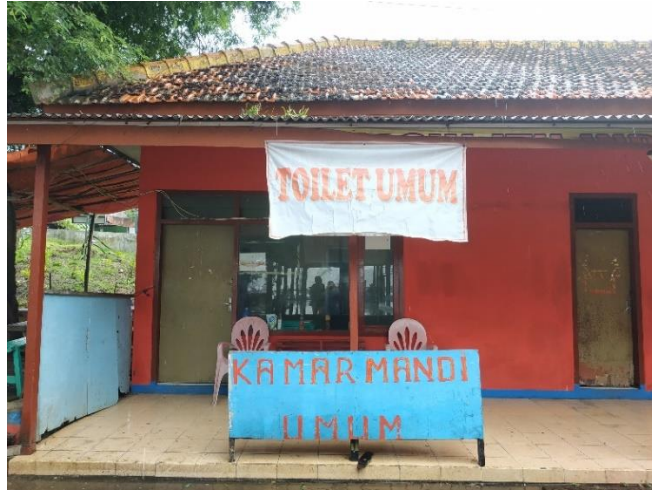
Gambar 1.10 Kamar Mandi Umum Samping Kantor Informasi
