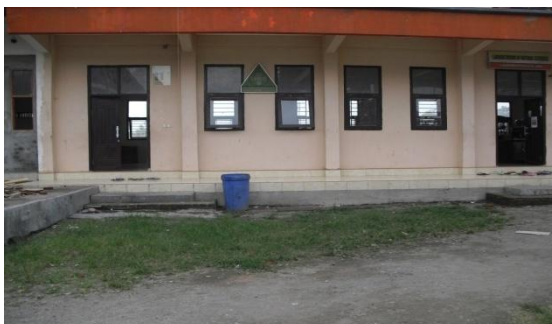
Gedung 05 SMA Mambaus Sholihin Blitar pada tanggal 12 Mei 2015
