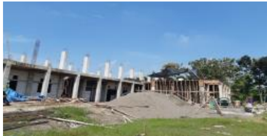
Gambar 4.16 : Proses pembangunan gedung SMP Tahfidz Al Hidayah
