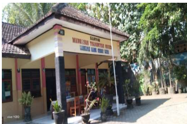
Gambar 4.1 Bangunan Depan MTsN 3 Langkapan Srengat Blitar
