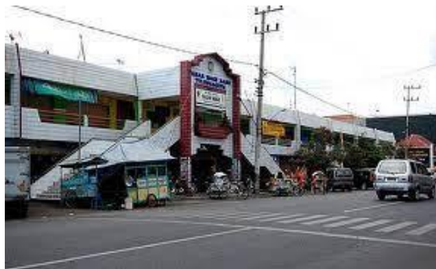
Gambar 4.1 Tampak Depan Pasar Wage Tulungagung
