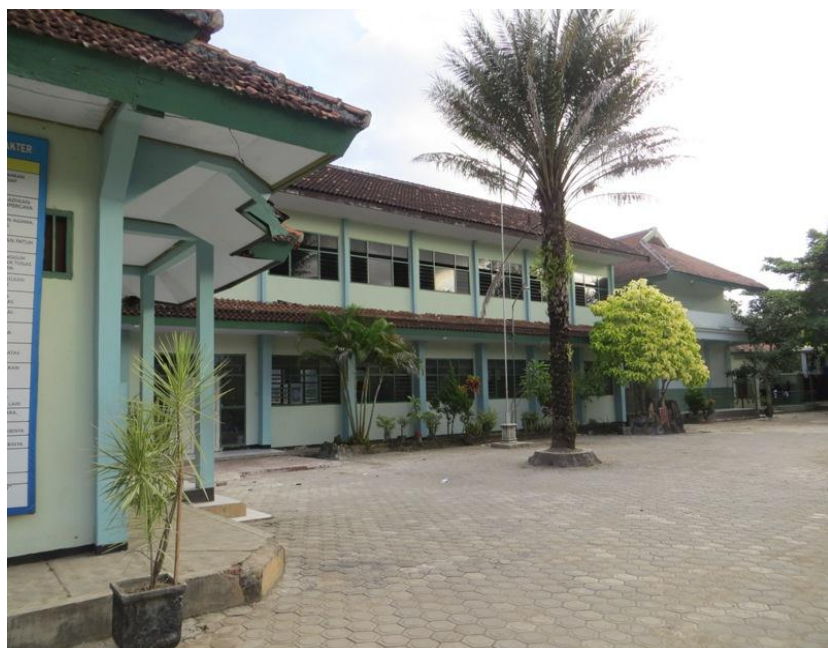
Gambar 4.7. Gedung Kelas MTsN Model Trenggalek
