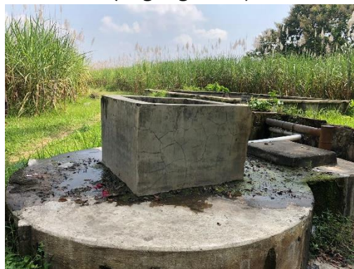
Gambar 4. Sumur untuk mengairi perkebunan Tebu di Ngunut
