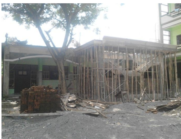
Gambar 4.2 Pembangunan ruang kelas 107
