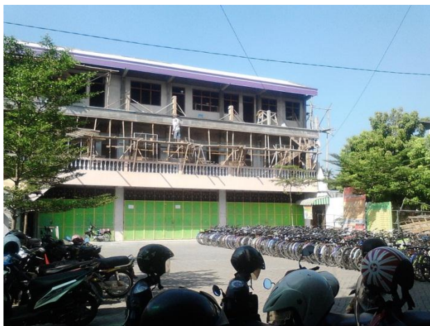
Gambar 4.4 Pembangunan ruang kelas
