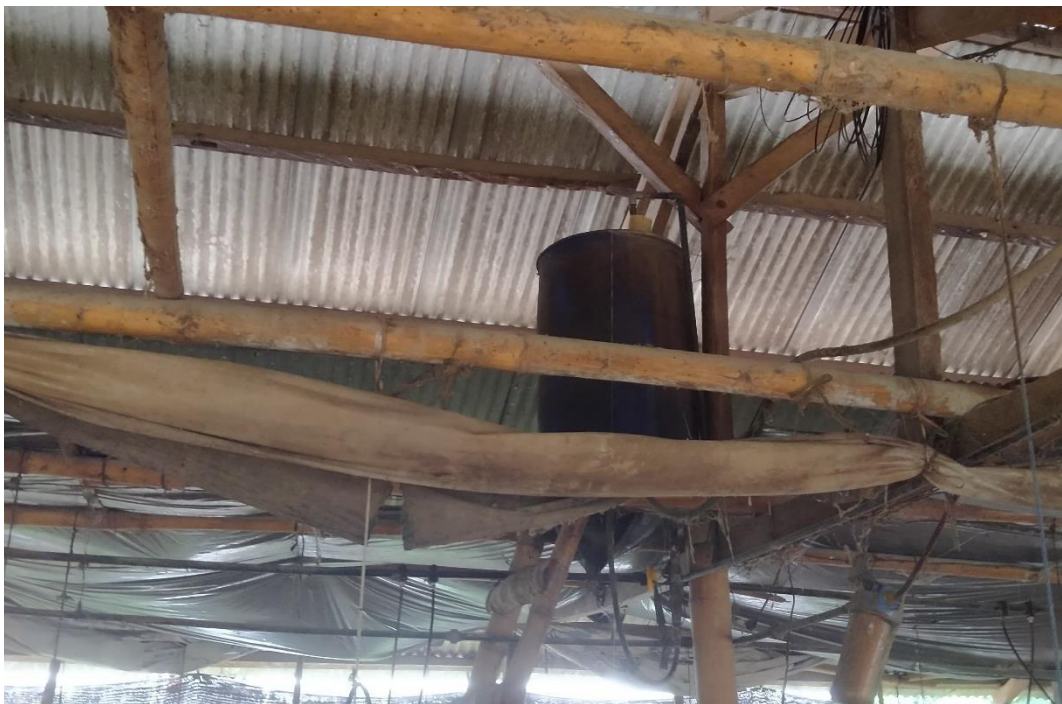
Gambar 6 Salah satu fasilitas tandon air pada kandang indukan
