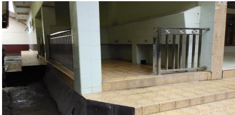
Gambar 1.6 tempat wudhu masjid Baitul Muttaqin SMPN 1 Ngunut Tulungagung. 28
