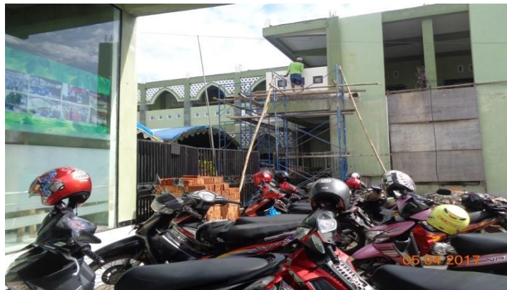
Gambar 4.14 Kondisi Gedung Sekolah yang Baru 62
