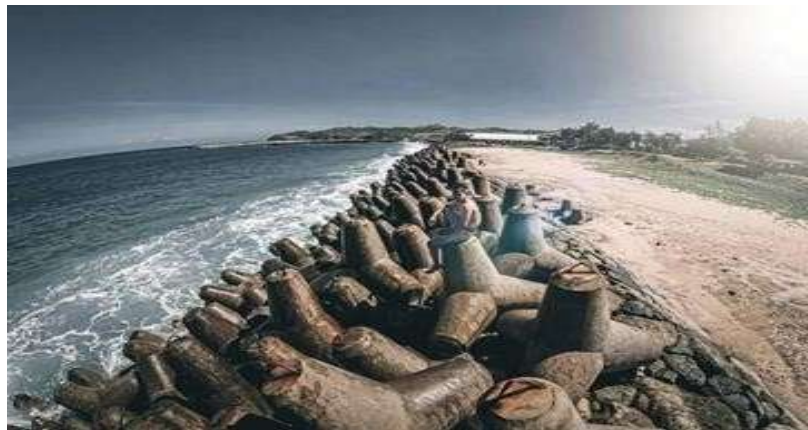
Gambar 1.5 Alat Pemecah Ombak (APO) di pantai Tambakrejo
